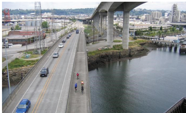
低橋--面向東方
